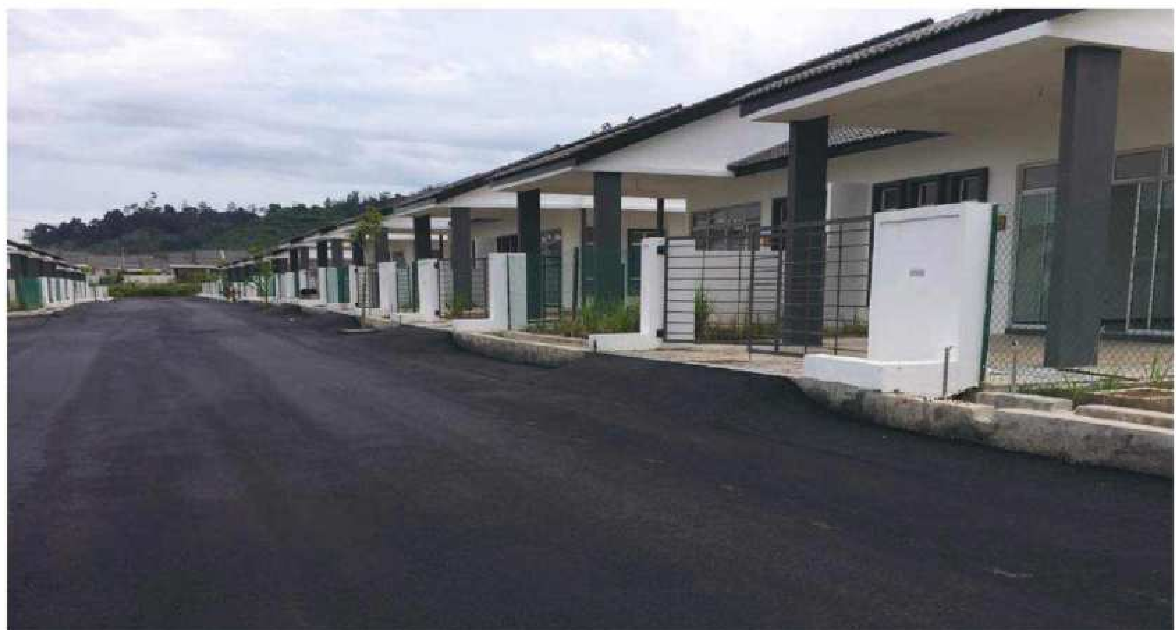
21 unit rumah teres 1 tingkat telah siap di bina di TSU perumahan Jerantut
