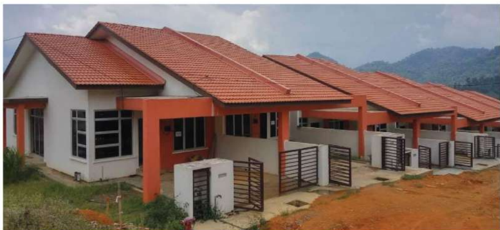
Projek Perumahan Chemperoh di Janda Baik, Bentong
